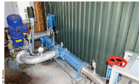
◀ Einen Teil des Fermenterinhalts insortiert Müller durch die Ultraschallanlage (rechts im Bild).
